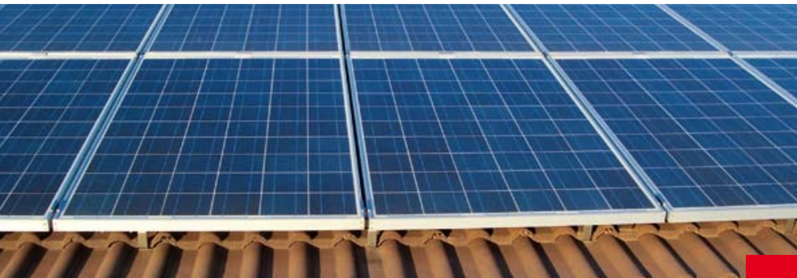
parzialmente integrato/partially building-integrated
